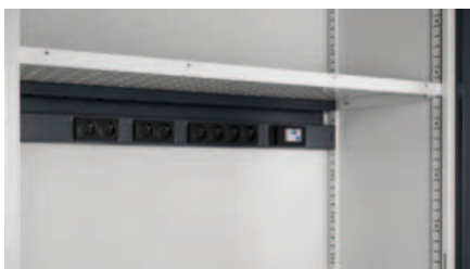
Applicazione canaletta elettrica sulla parte inferiore del piano-pannello forato
